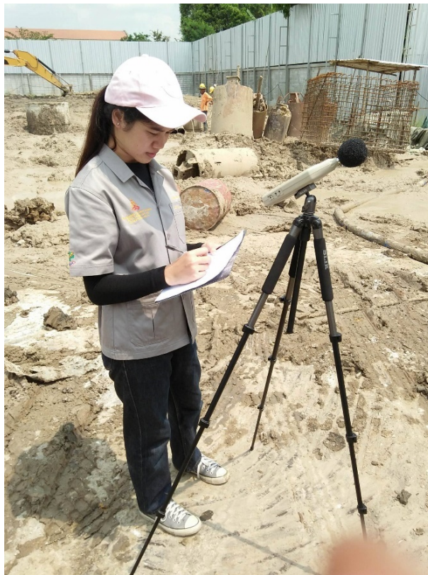
ภาพที่ 4.14 การติดตั้งเครื่องวัดเสียงกรณีพนักงานทำงานหลายงานใน 8 เซนติเมตร
