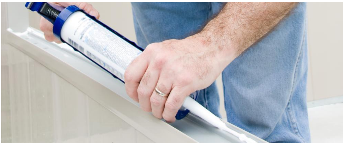
รูปที่ 8.15 ซิลิโคนใช้ยึดเป็นกาว เพื่อกันรั่วและความชื้น
