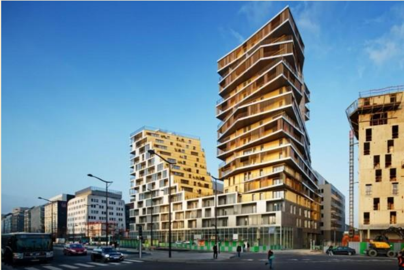
ภาพที่ 21 สถาปัตยกรรมออกแบบด้วยรูปทรงต่อเติม อาคารพักอาศัย ZAC MASSENA BUILDING – PARIS (FR) ออกแบบโดย Hamonic & Masson (Euramax Coated Products, 2015)
