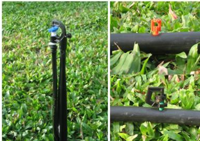
ระบบรดน้ำเหนือดิน
