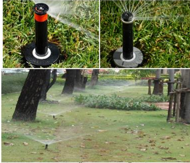
ระบบรดน้ำใต้ดิน
