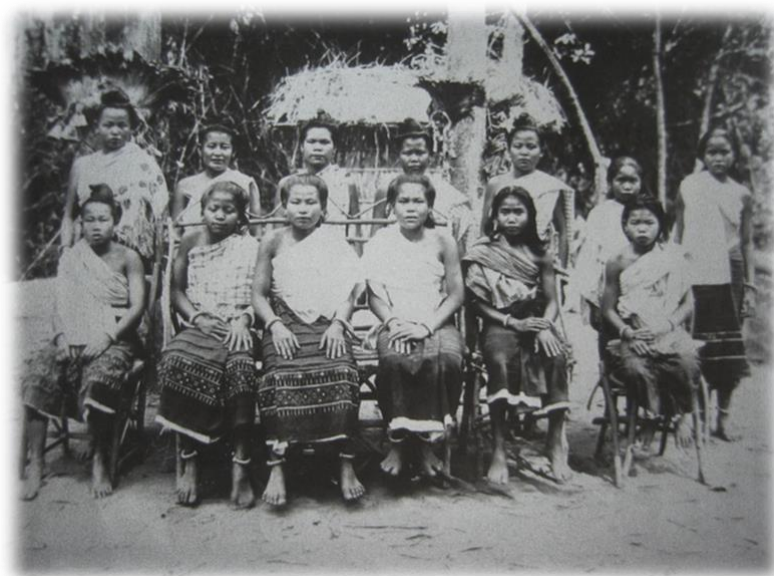
ภาพที่ 1.18 การแต่งกายสตรีของชาวบ้านภาคเหนือในอดีต
