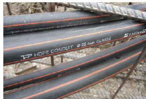
ท่อ HDPE ใช้ร้อยสายไฟใต้ดิน
